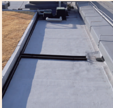
FDウォールGRC+RK排水ガイドの施工例
