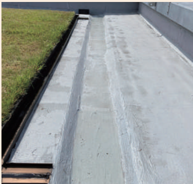
FDウォール100R+RK排水ガイドの施工例
